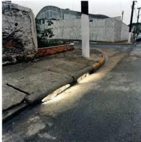
FOTOGRAFÍA 9 * ALCANTARILLA, RUBENS MANO (1994)
