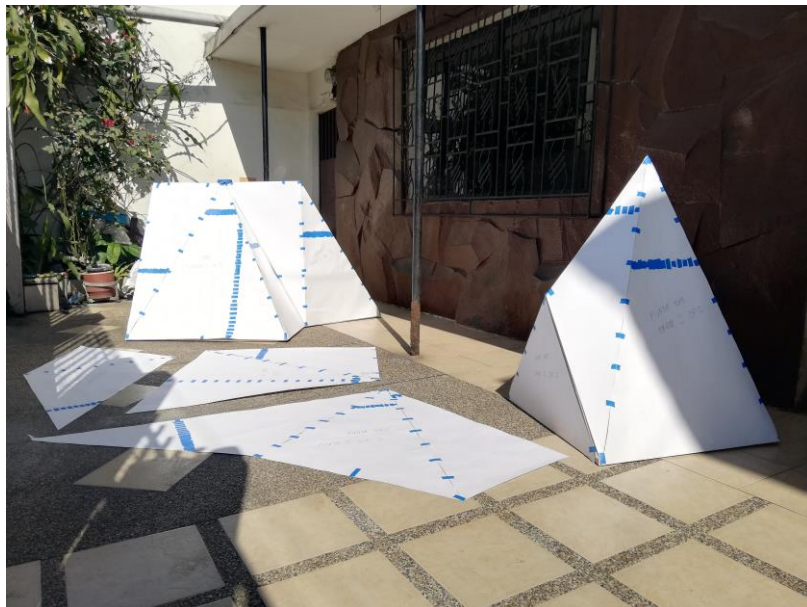
Estructura cubierta con moldes de papel.
