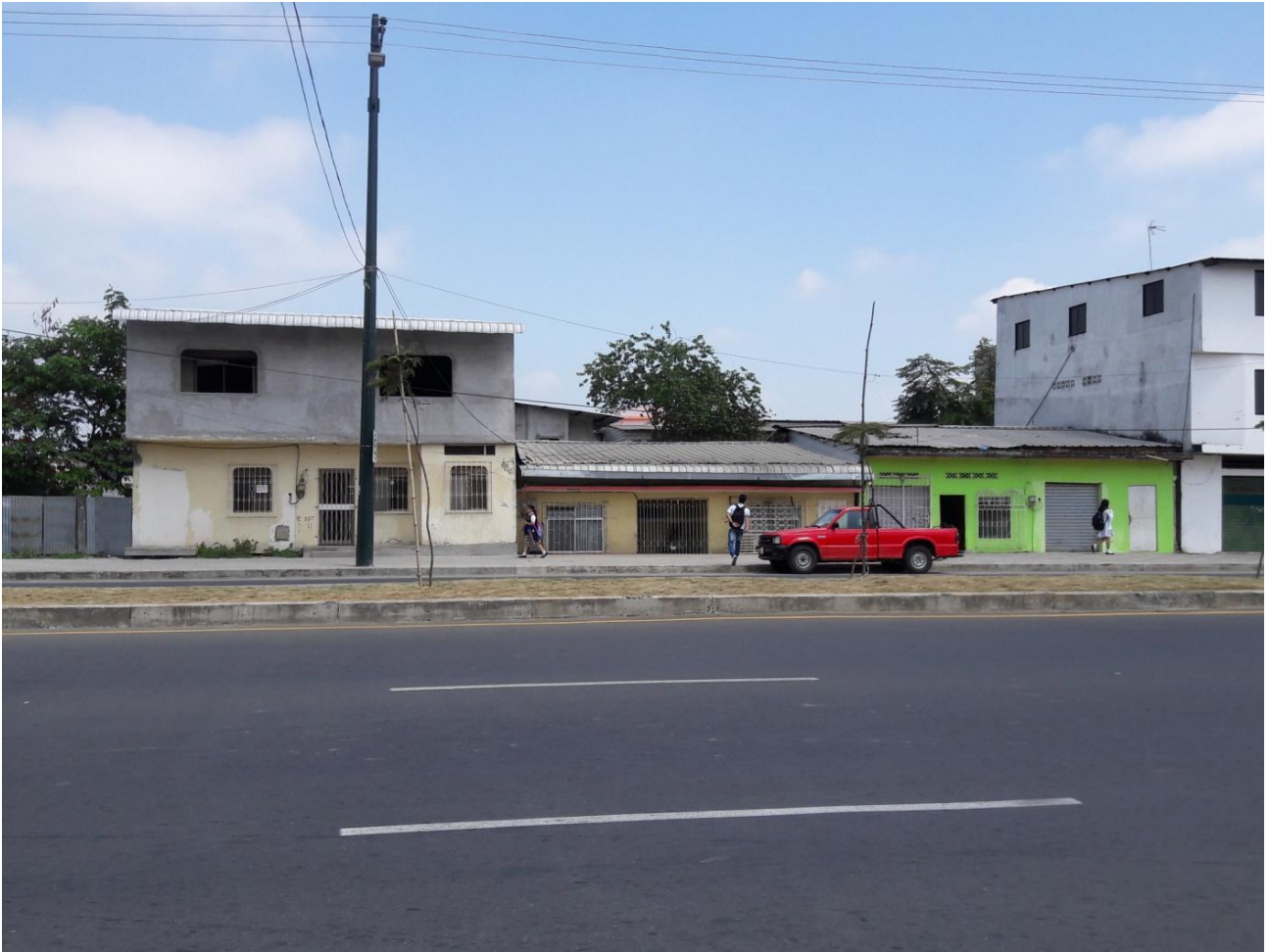
Registro fotográficos de casas enterradas en la ciudad de Babahoyo. 2017
