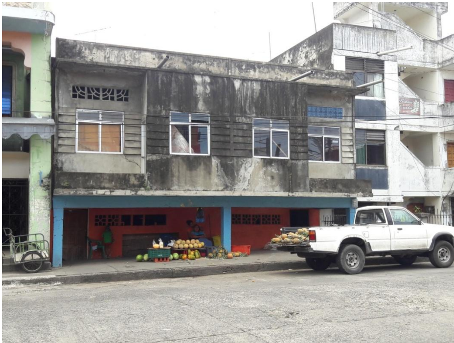
Registro fotográfico de espacios de Babahoyo. 2017
