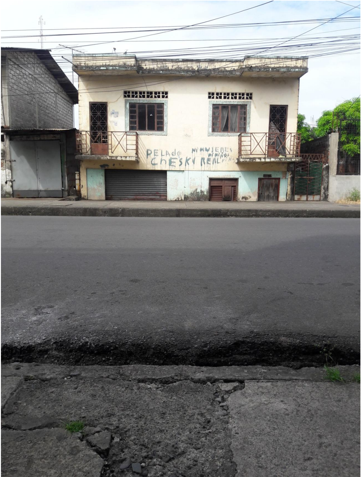
Registro fotográficos de casas enterradas en la ciudad de Babahoyo. 2017
