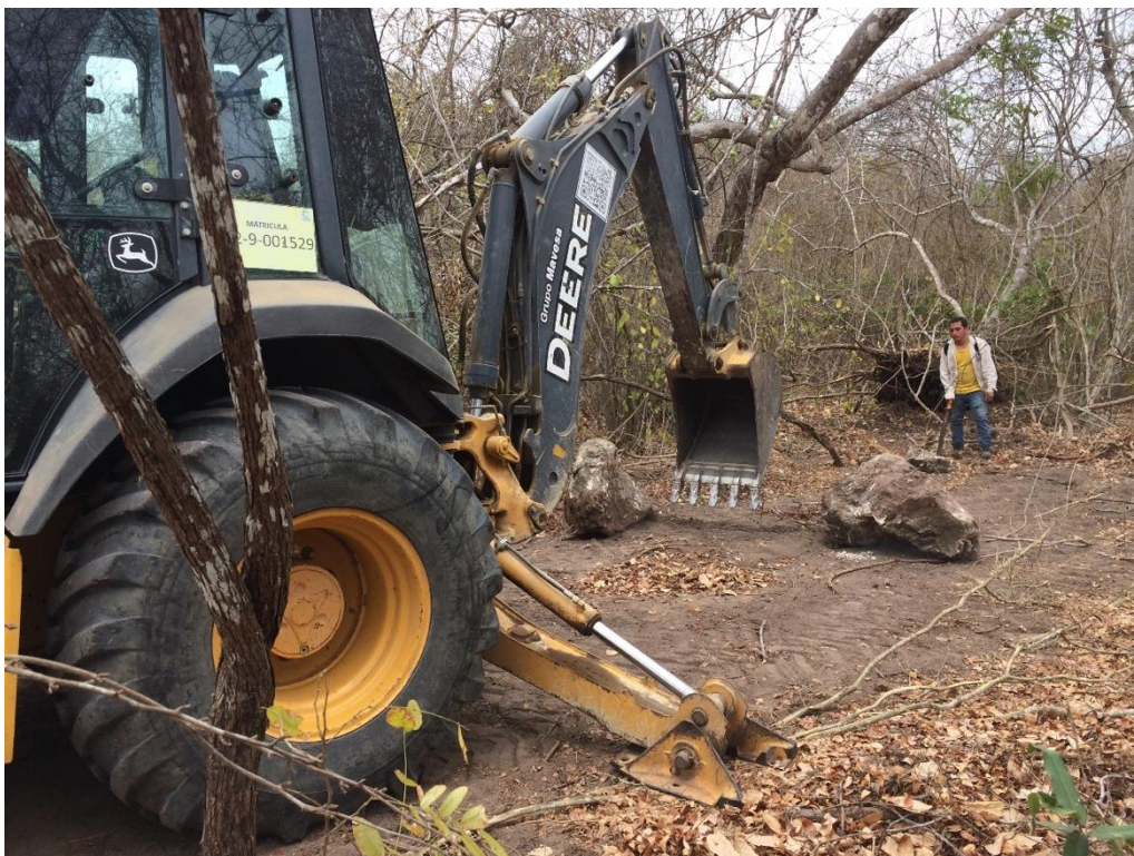
Figura 22 Registro Proceso de extracción de la roca
