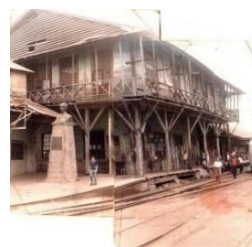
Fig. 53. Antigua estación de Durán Fuente: Fondo Nacional de Fotografía
