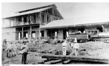
Fig. 10. Construcción estación. Fuente: HMCE
