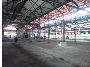
Fig. 78. Galpón Talleres viejos-Ferrocarriles. Donde se ubica el horno, los calderos, las máquinas y las piezas de madera
