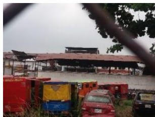
Fig. 52. Lo que queda de la estación de trenes-Durán 2019 Fuente: Silvia Quezada
