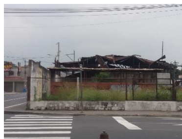
Fig. 40. Estructura estación centro de Durán, 2019 Autor: Syl Quezada
