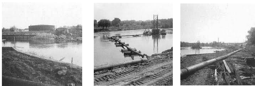
Fig. 56. Recorridos por los monumentos de Passaic New Jersey de Roberth Smithson
