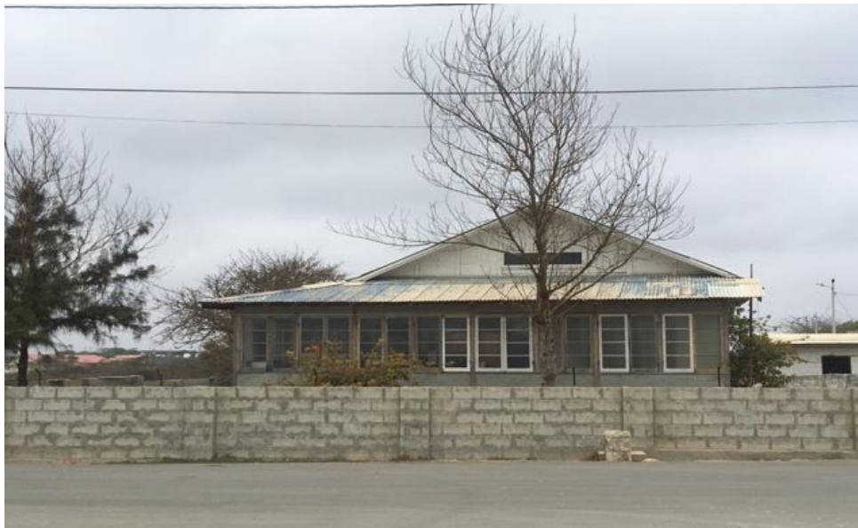
Imagen 2. Primera casa, fachada.
