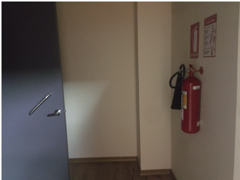
Fig. 42: Ingreso a la sala principal.
