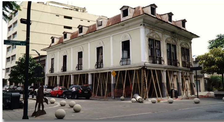
Imag. 7 “Casa Cacaotera”, vista de perfil inicios del (2019)
