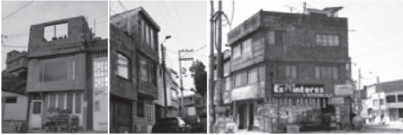
Imagen 36. Casa de autoconstrucción en el sector de Cerros Orientales, Bogotá, 2014. / Imagen 37. Casas de autoconstrucción en el sector Plaza Norte, Tunja, 2015. / Imagen 38. Casa de autoconstrucción, Autopista sur, Soacha, 2012. / (Fotografías del autor)
