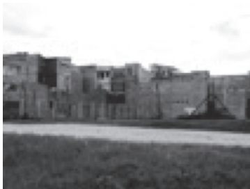
Imagen 35. Muros con huellas de distintas etapas en casas de autoconstrucción, barrio El Refugio, Fontibon, 2015. (Fotografía del autor)
