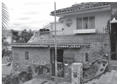
Casa Lakomuna. Exterior. Gradas del Otorongo
