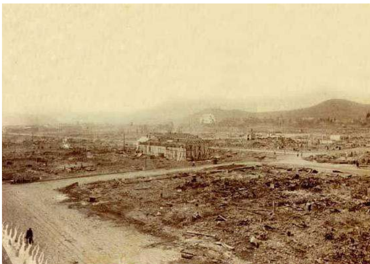
(Fig. 2.1) Fotografía de los restos del incendio de 1896. 34
