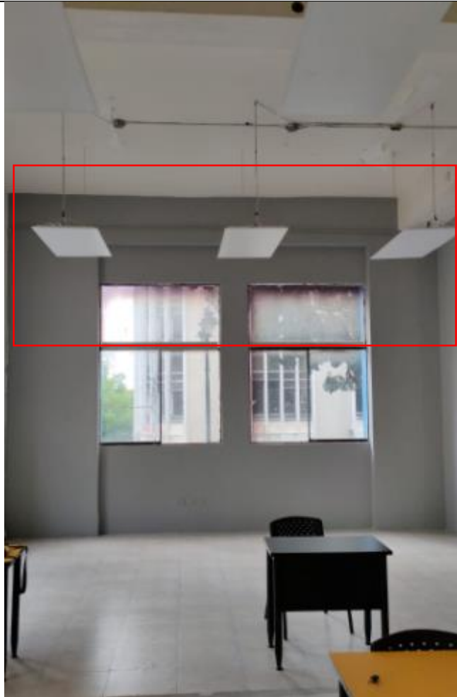
Ilustración 21 Nivelación de luminarias led
