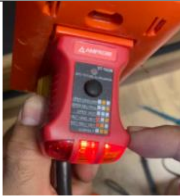
Ilustración 43 Tomacorriente de alimentación de consola
