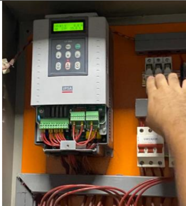
Ilustración 37 Revisión de conexiones internas
