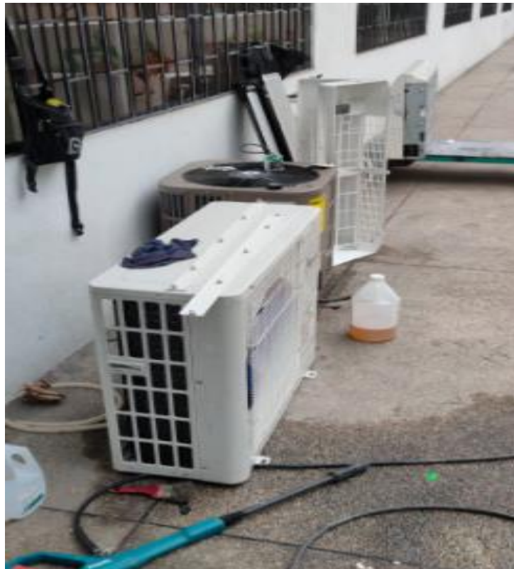
Ilustración 24 Mantenimiento de equipos de climatización
