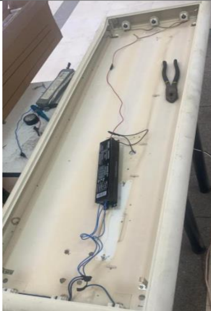
Ilustración 13 Procedimiento para el cambio de luminarias Fluorescentes
