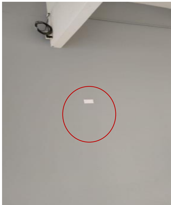
Ilustración 22 Colocación de tapa eléctrica ciega
