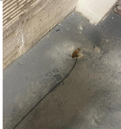
Ilustración 50 Barra de cobre en cuarto de distribución
