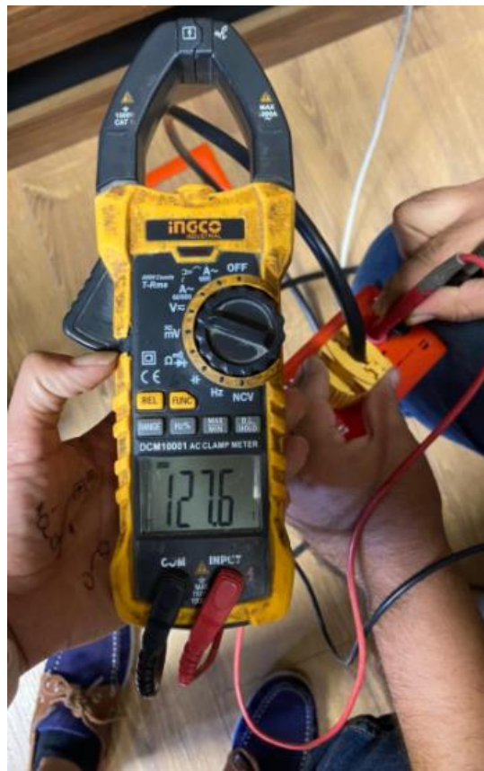
Ilustración 59 Voltaje en tomacorriente
