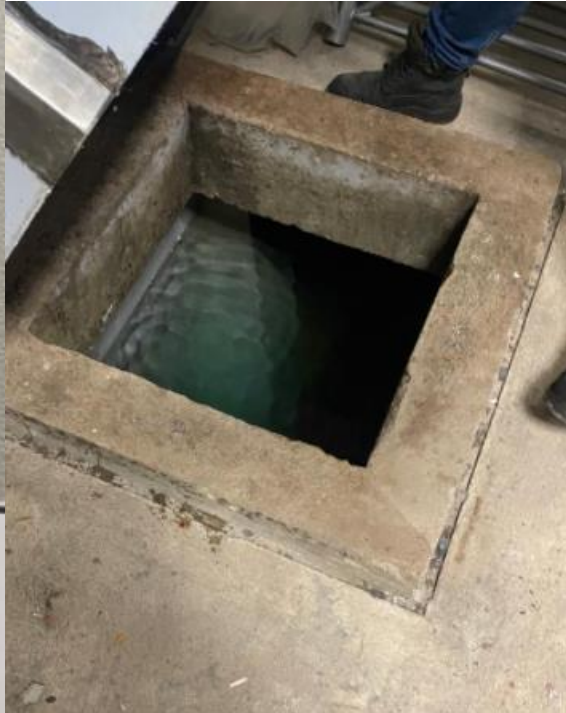
Ilustración 40 Revisión de nivel
