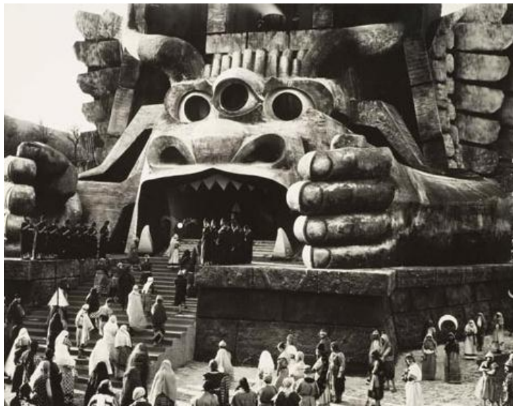
Set construido para Cabiria .
